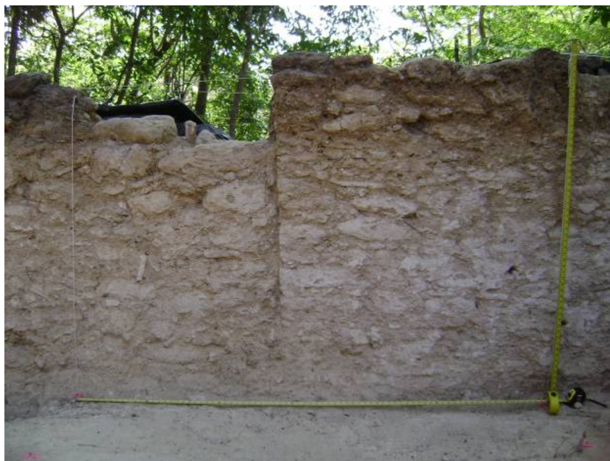
Figura 4.6 Fachada Oeste del muro posterior de la superestructura de 13Q-2 (unidad CR32C-5)
