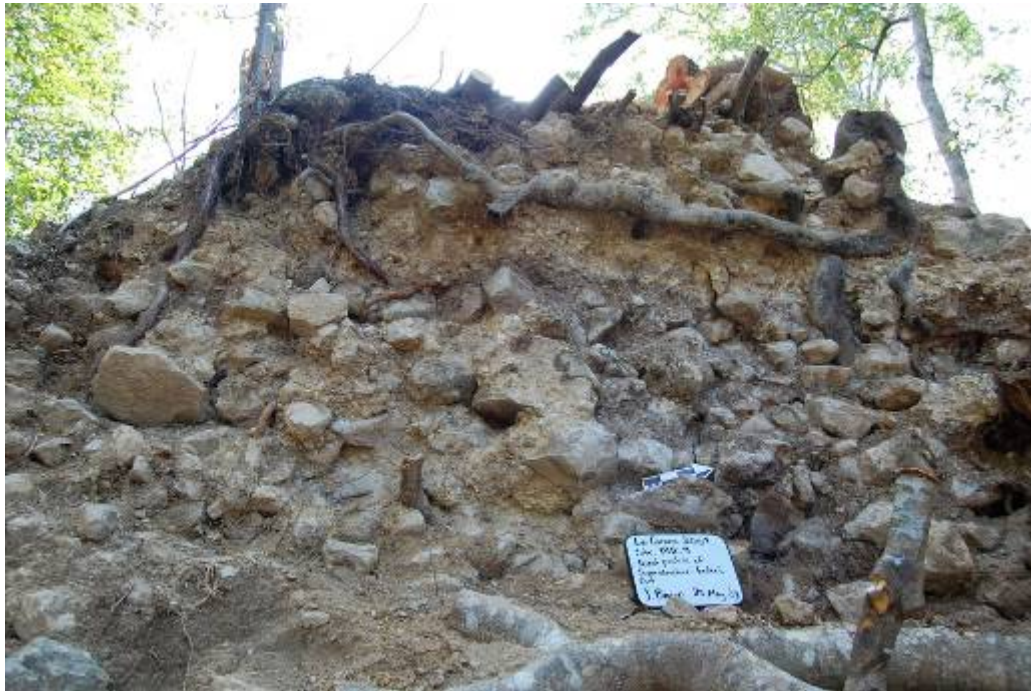
Figura 6.12 Perfil Oeste del relleno de la superestructura expuesta por la trinchera de saqueo
