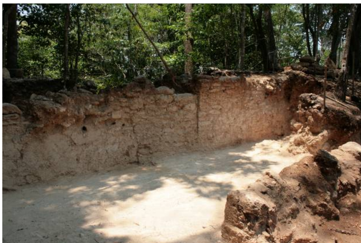
Figura 4.7 Fachada oeste del muro posterior de la superestructura de 13Q-2
