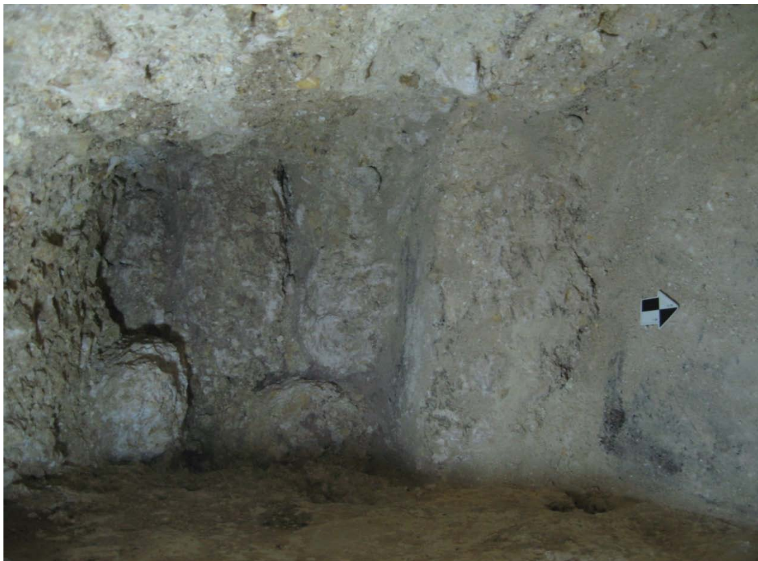
Figura 3.9 Perfil Norte del Túnel 10, Subestructura Jonon (Foto por M. Acuña)
