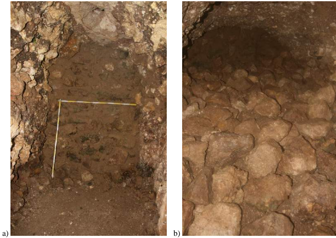
Figura 14.15 a) Muro y b) relleno dentro del Túnel #15 (Fotografías por E. Arredondo).
