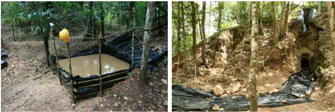
Figura 14.2 Recolección de agua de lluvia, utilizando plástico y la pendiente de la Estructura 5C-01 (Fotografía por E. Arredondo).
