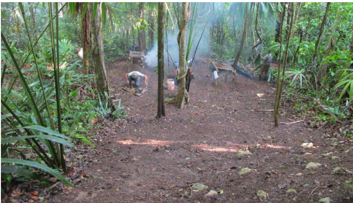
Figura 13.42 Piedras descendiendo desde la cima de la terraza superior hacia la terraza central. Las piedras probablemente sean restos del muro de contención colapsado. Unidades ACH99-21 y ACH99-22 (Fotografía por L. Auld-Thomas).
