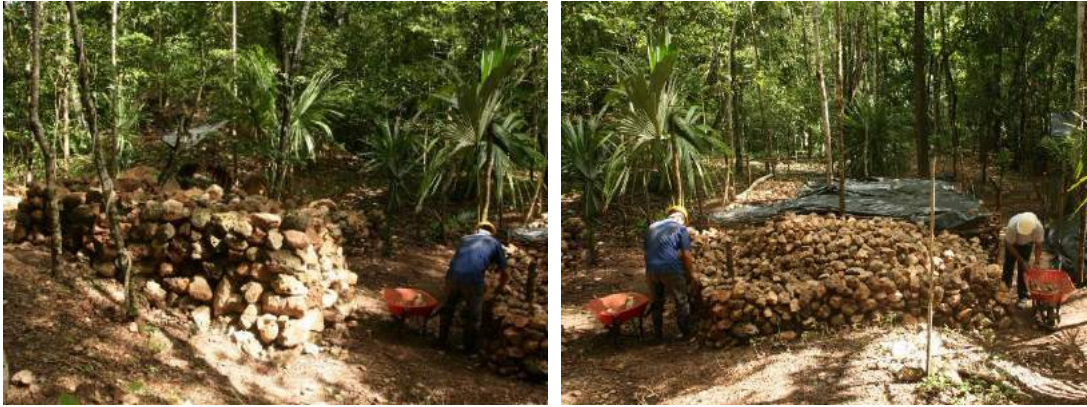
Figura 14.1 Recolección y selección de piedra (Fotografía por E. Arredondo).
