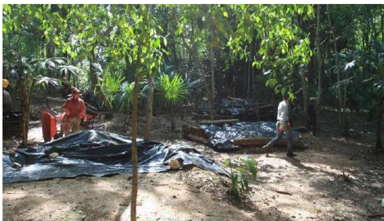
Figura 14.37 Proceso de limpieza y protección de material sobrante (Fotografía por E. Arredondo)
