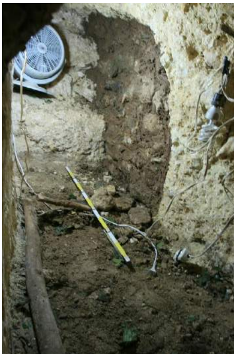
Figura 14.10 Muro de cierre del Túnel 11 (Fotografía por E. Arredondo).
