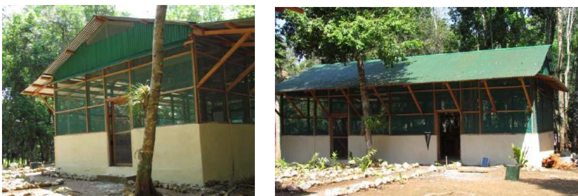
Figura 1.25 Edificios de oficina y bodega de materiales y herramientas, campamento PRALC (Fotografía T. Barrientos).
