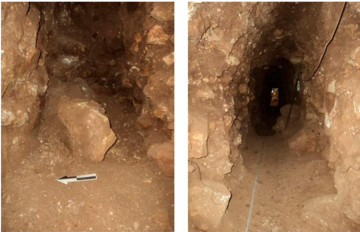
Figura 6.9 Piedras de gran tamaño como parte del relleno excavado y algunas no removidas de la ruta del túnel debido a su volumen (Fotografías por R. López).
