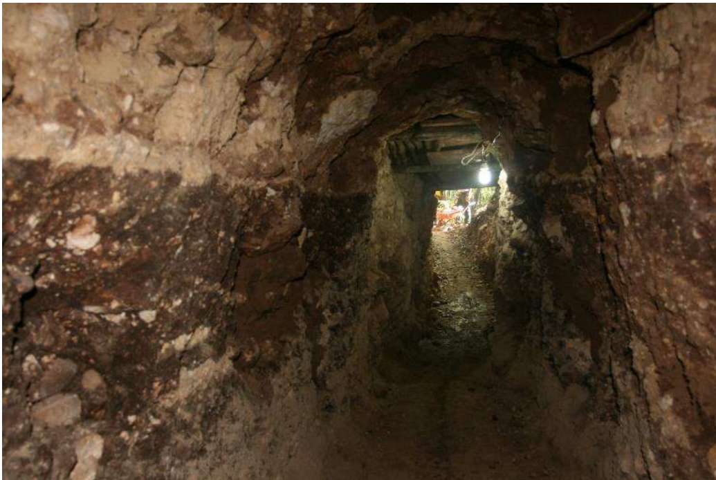
Figura 14.14 Vista general del Túnel 15 desde el interior hacia el norte (Fotografía por E. Arredondo).
