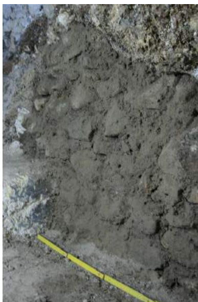
Figura 14.6 Muro de cierre al finalizar el relleno del Túnel 10 (Fotografía por E. Arredondo).
