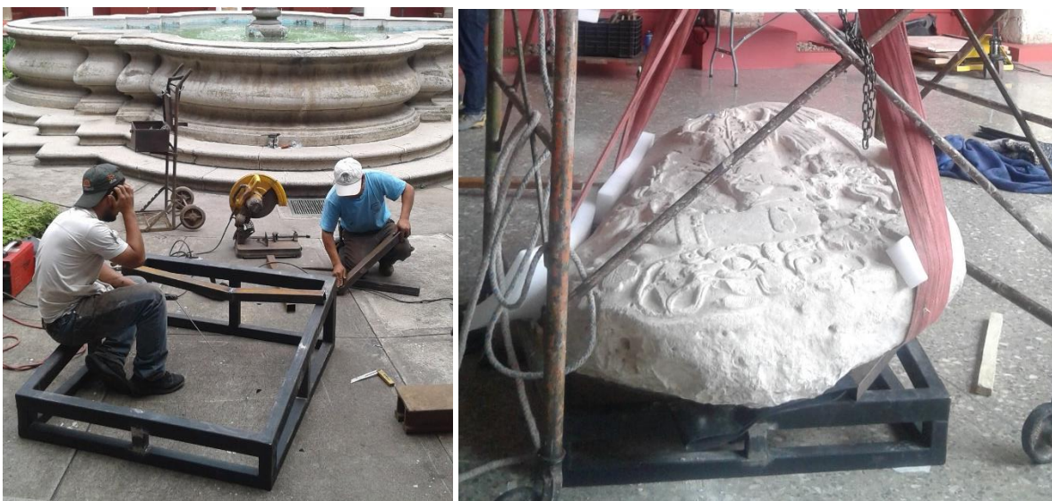
Figura 4.10 Elaboración y ajuste de la base de metal del monumento (Fotografías por T. Barrientos)
