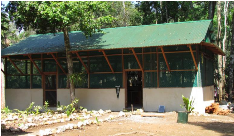
Figura 1.18 Edificios de oficina y bodega de materiales y herramientas, campamento PRALC (Fotografía T. Barrientos)
