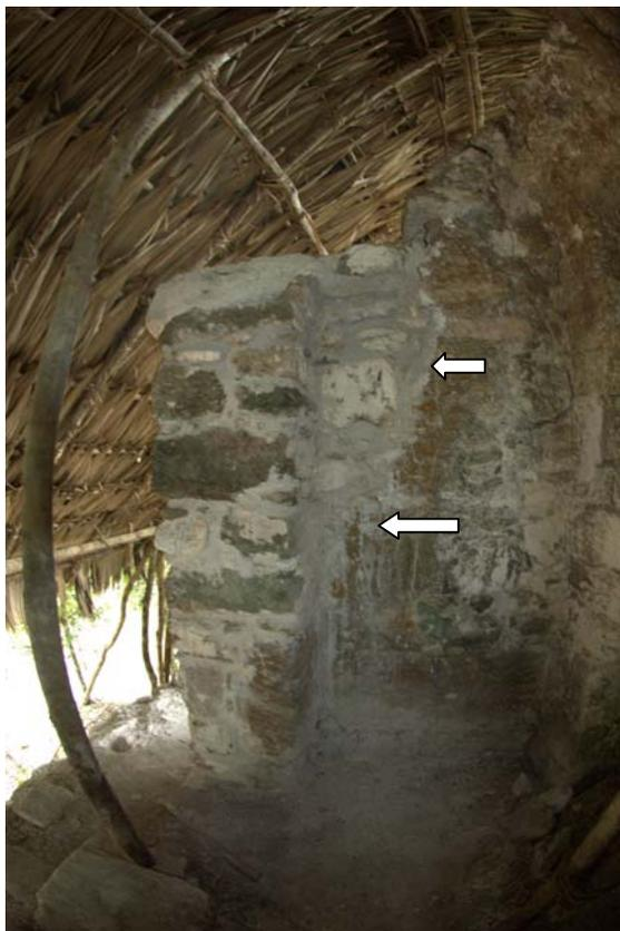
*Figura 1.7 Reparación de la esquina y cornisa del muro oeste del Edificio B, fase 5ª.*
