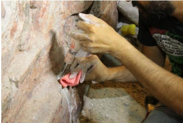
Figura 8.20 Inyección de lechada de cal en oquedades (Foto: M. Colín).
