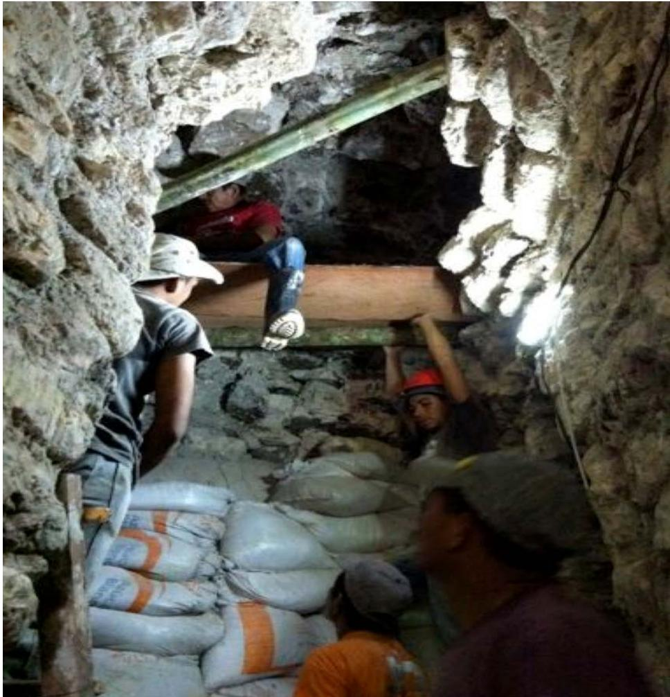
Figura 7.4 Vista al interior del Túnel 1 con el Mascarón Norte, Estructura 1, protegido con costales de tierra. Construcción de puntales para prevenir derrumbes del techo de la excavación (Proyecto Arqueológico Holmul, A. Coronado).
