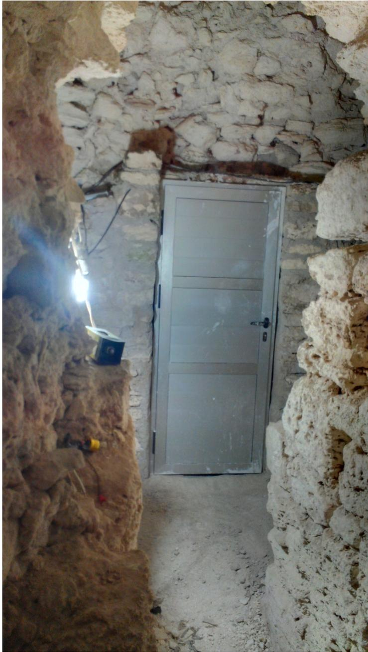
Figura 1.14 Puerta de aluminio con empaques de hule en la cámara interior de la última fase del Edificio A de Holmul.
