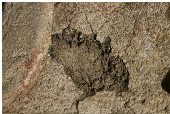
Figura 8.6 Raicillas entre el soporte y el estuco que provoca disgregación de material (Foto: M. Colín).
