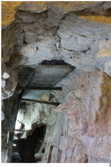
Figura 8.10 Vista del túnel, donde se observa una tabla y puntales de madera para sostener parte del relleno (Foto: M. Colín).
