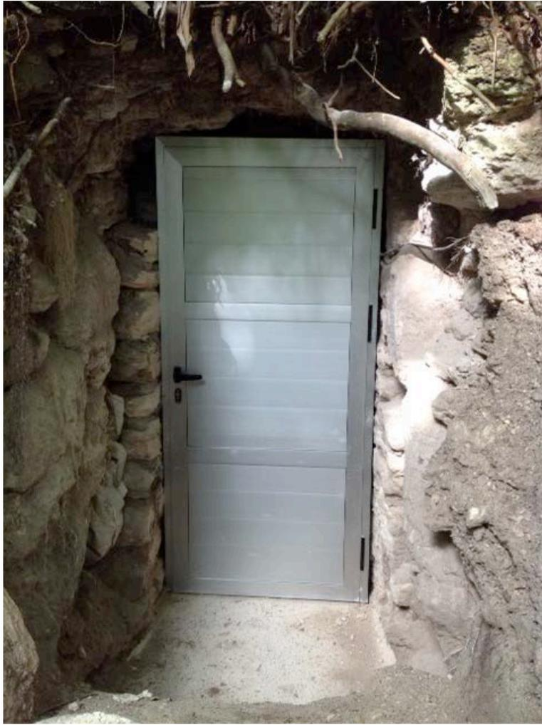
Figura 7.7 Instalación de puerta de aluminio en la entrada del Túnel 1, Estructura 1 (Proyecto Arqueológico Holmul, A. Coronado).
