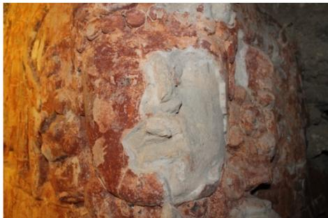
Figura 8.19 Resultado final después de los ribetes. En estas secciones no debe realizarse reposición de faltantes (Foto: M. Colín).
