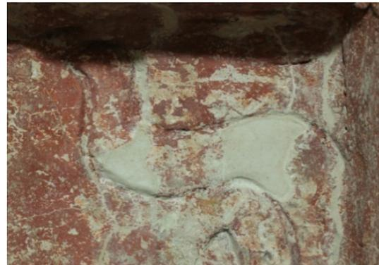
Figura 8.18 Resane y pequeña reposición debido a que existe la evidencia formal del faltante (Foto: M. Colín).
