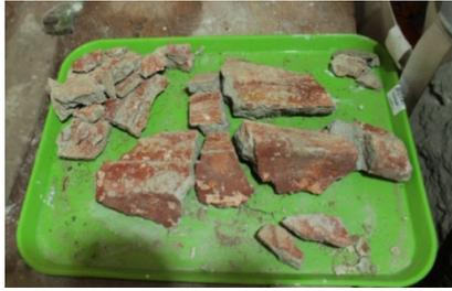
Figura 8.17 Los fragmentos retirados se colocaron temporalmente en bandejas antes de ser adheridos nuevamente (Foto: M. Colín).
