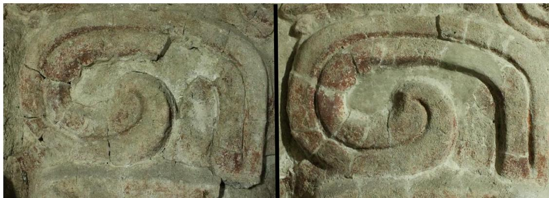
Figura 2.13. (Izquierda). Voluta al inicio de la temporada, hay faltantes en el relieve y diversas grietas. Figura 2.14. (Derecha). Mismo detalle después de tratamientos. La consolidación y resane evitaran que el estuco se desprenda, además de que mejoran notablemente las características formales de la forma. Fotos: M. Colín.
