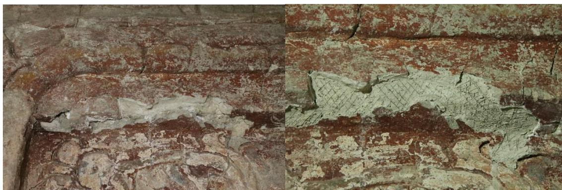
Figura 2.9. (Izquierda). Esquina de panel con pérdida de aplanado. Figura 2.10. (Derecha). La sección faltante de aplanado fue resanada con varias capas de mortero; en la imagen se aprecia que la superficie tiene textura reticulada, que mejora el anclaje de la siguiente capa de mortero. Fotos: M. Colín.
