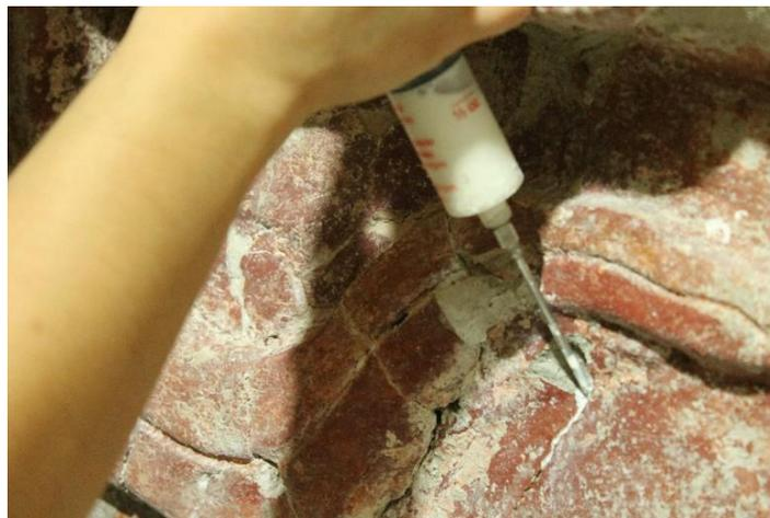
Figura 2.4. Aplicación de lechada de cal por goteo e inyección.
