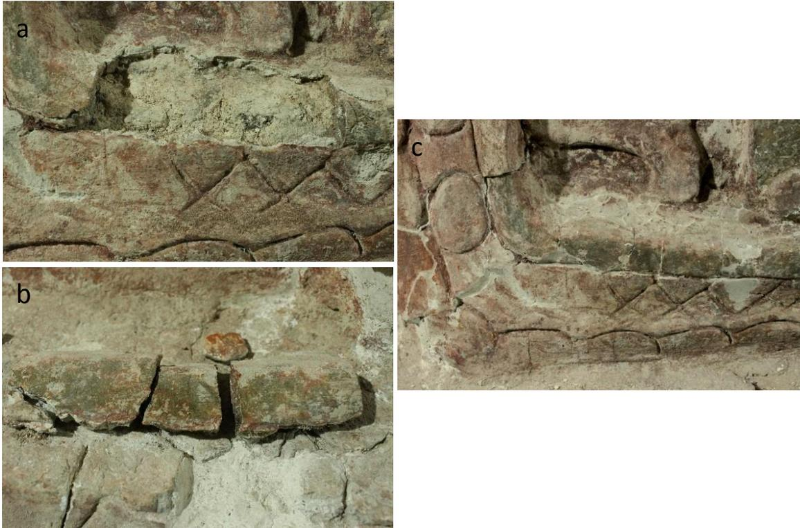
Secuencia de intervención. Figura 2.5. (a). Desprendimiento de estuco por oquedad y grietas. Figura 2.5. (b). Colocación de fragmentos. Figura 2.5. (c). Resultado con fragmentos pegados y resanados. Fotos: M. Colín.
