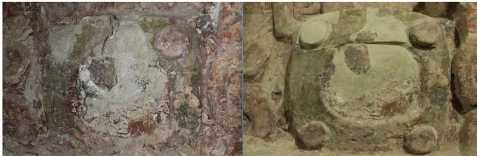
Figura 2.4. (Izquierda) estuco modelado con faltantes que dejan ver la piedra expuesta. Figura 2.5. (Derecha) misma sección después de proceso de resane y reposición.
