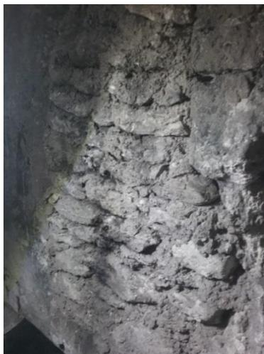
Figura 4.127. Muro norte (HOL.T.93.43) con el vano de acceso tapiado por un conglomerado de argamasa y piedras de relleno (HOL.T.93.09).
