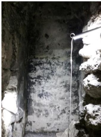
Figura 4.130. Muro este (HOL.T.93.42) estucado con bóveda en forma de “botella”.
