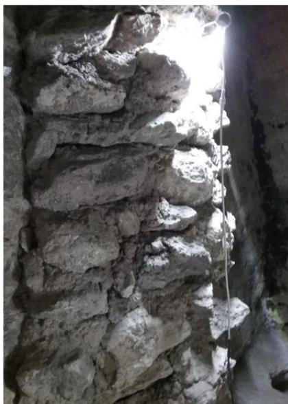
Figura 4.128. Muro norte (HOL.T.93.44) con el vano de acceso tapiado por un conglomerado de argamasa y piedras de relleno (HOL.T.93.41).
