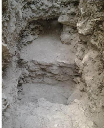
Figura 9.4. Muro de contención, material apisonado y material de relleno.
