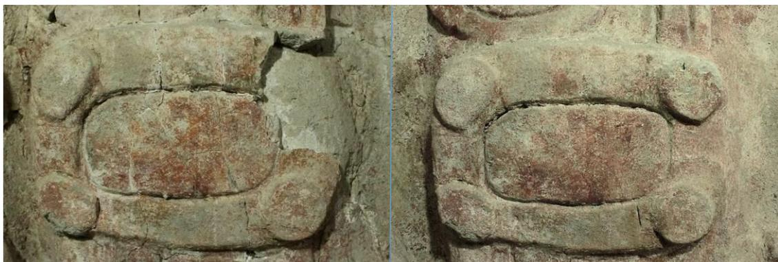
Figura 2.15. (Izquierda). Detalle antes de procesos. Figura 2.16. (Derecha) misma sección después de tratamientos. Fotos: M. Colín.
