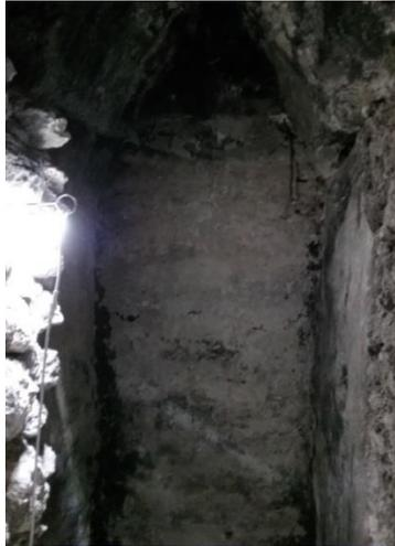
Figura 4.129. Muro oeste (HOL.T.93.45) estucado con bóveda en forma de “botella” y la intrusión de flora y fauna al extremo norte del intradós.
