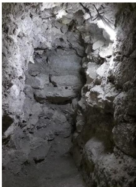
Figura 4.110. A la Izquierda se muestra un vano de acceso tapiado por conglomerado de argamasa y piedra burda (HOL.T.93.05)
