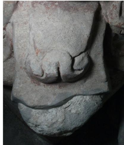
Figura 3.5. Sección inferior de esquina suroeste, piedra consolidada con lechada y mortero, ribetes en bordes. Foto: M. Escalante.
