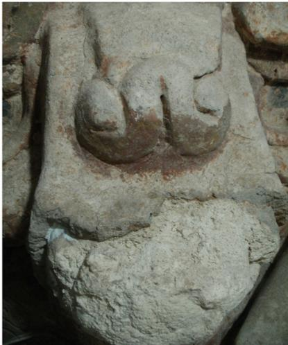
Figura 3.4. Sección inferior de esquina suroeste, con pérdida de estuco y piedra expuesta. Foto: M. Escalante.
