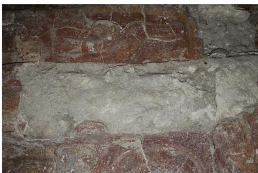
Figura 3.6. Sección superior de panel noreste, con pérdida de relieve y piedra expuesta. Foto: M. Escalante.
