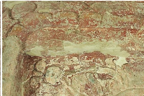
Figura 3.11. Sección superior de tercer panel a mitad de procesos en 2016, con resanes de grietas y reintegración formal de relieves. Foto: M. Colín.
