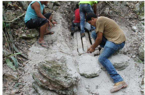
Figura 3.14. Remoción de tablonces de madera que cubrían la lumbrera del túnel. Foto: M. Colín.
