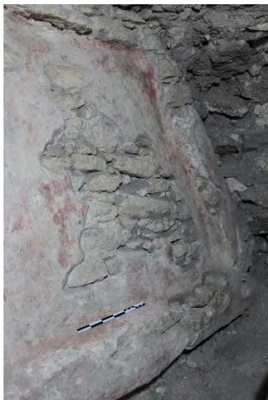
Figura 3.34. Límite Este del muro Sur solo con ribetes para estabilizar. Se observan los sillares por pérdida de aplanado (Foto: M. Colín)
