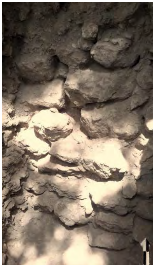
Figura 2.16. Vista sur del paramento HOL.T.104.03, conformado por piedras irregulares (Foto: Berenice García Vázquez).
