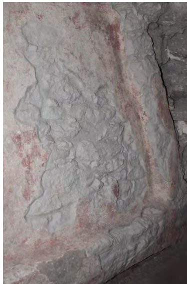
Figura 3.35. Límite Este del muro Sur después de tratamientos. (Foto: M. Colín)
