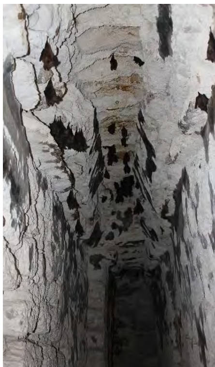
Figura 3.6. Túnel de acceso hacia la subestructura, vista desde la entrada al friso. Se observa parte de la colonia de murciélagos en la bóveda. (Foto: M. Colín)
