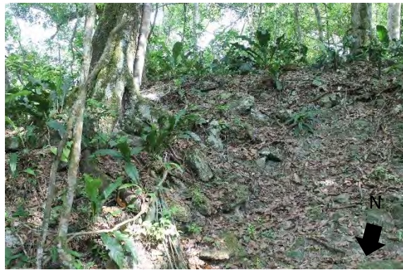
Figura 3.2. Superficie exterior del Edificio A. Se observa parte de la flora que afecta los muros Norte y Oeste. (Foto: M. Colín)
