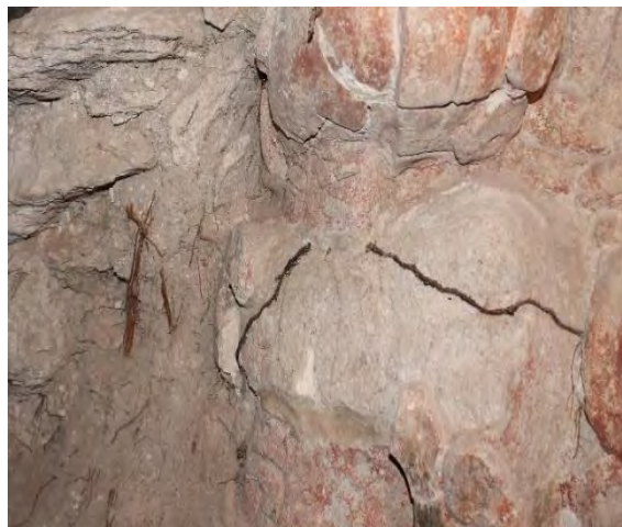
Figura 3.3. Esquina Noroeste con galerías de termitas sobre el estuco. (Foto: M. Colín).
