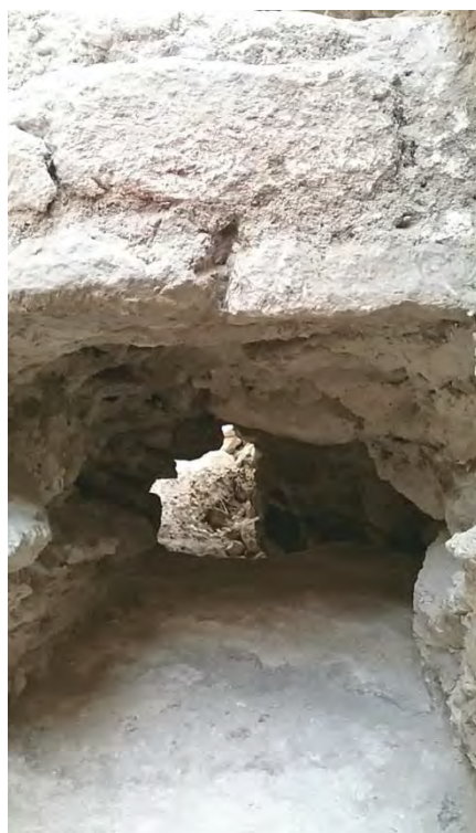
Figura 5.12. Vista del túnel construido bajo la escalinata (WIT.T.14.09) (Foto K. Ahern).
