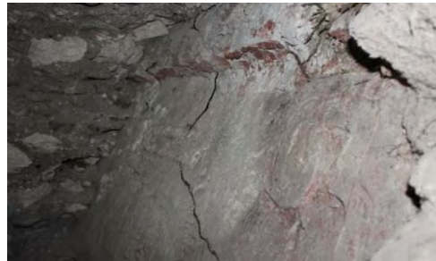
Figura 3.8. Muro Norte, vista desde esquina Oeste hacia Este. Hay múltiples grietas, desprendimientos, raíces y material de relleno. (Foto: M. Colín)
