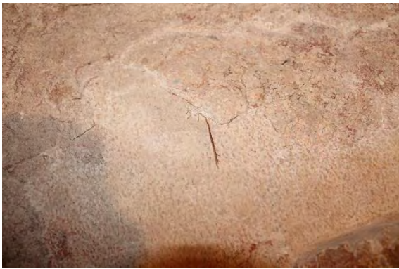
Figura 3.1. Detalle de primer panel, muro Oeste. En la parte superior hay crecimiento de raicillas que desprendieron el aplanado de estuco. (Foto: M. Colín)
