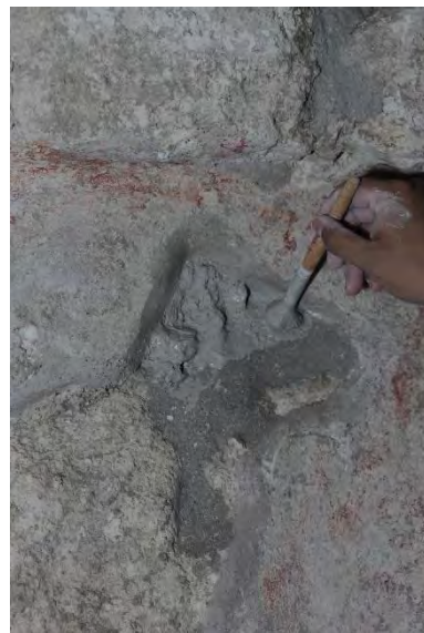
Figura 3.33. Aplicación de lechada con arena fina como acabado final en zonas con pérdida de aplanado. (Foto: M. Colín)
