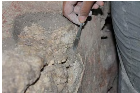
Figura 3.29. Resane de aplanado en muro Sur. (Foto: M. Colín)
