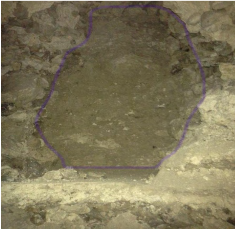
Figura 6.9. Muro de contención (WIT.L.20.07) marcado con color, se observa el relleno junto al muro, el piso destruido y el relleno debajo del piso (Foto de B. Girón).
