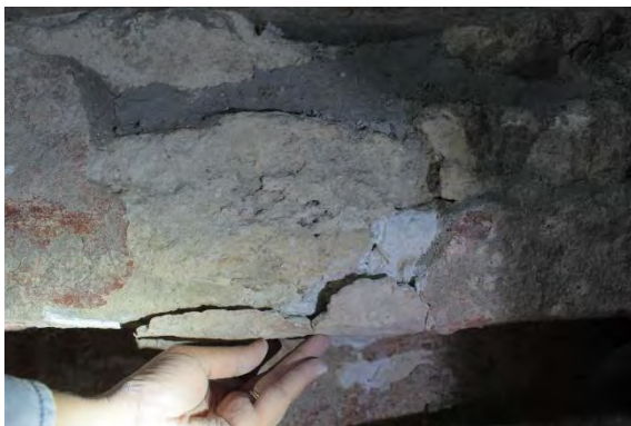
Figura 3.32. Colocación de fragmentos desprendidos en muro Sur. (Foto: M. Colín)
