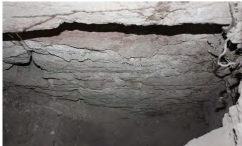
Figura 3.7. Muro Norte, sondeo de arquitrabe donde se observa la pérdida de aplanado y sillares expuestos. (Foto: M. Colín)
