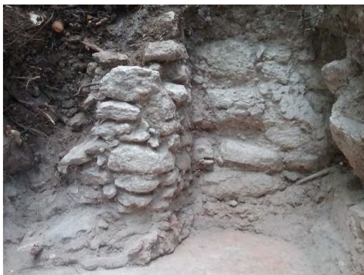
Figura 8.2. Jamba colapsa por efecto natural de las raíces y muro oeste. Contextos WIT.T.11.09 y 13 (Foto E. Quinac).
