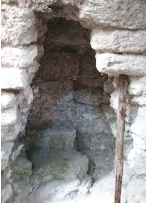
Figura 5.5. Vista de la entrada del túnel y de la pared WIT.T.13.15 (Foto K. Ahern).
