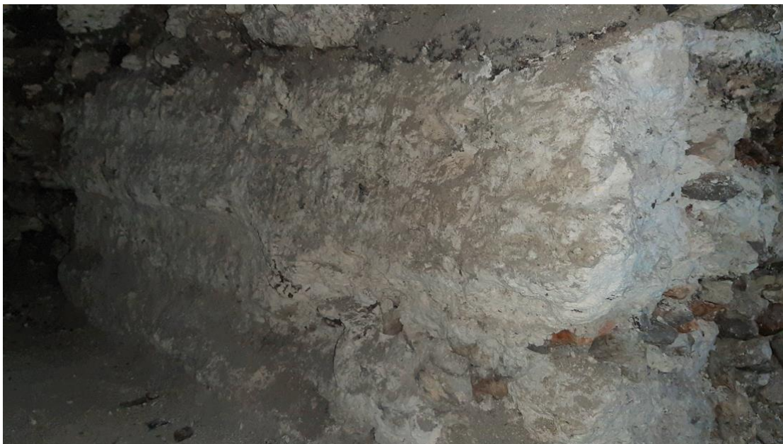
Figura 3.14. Fachada sur de la Plataforma de la quinta última fase constructiva. vista noroeste, se observa molde remetido. (Foto C. Enríquez).
