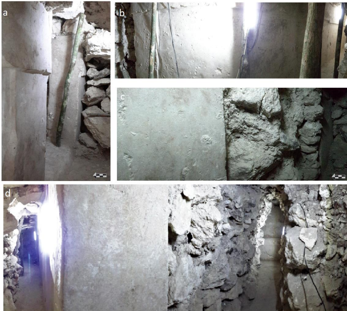
Figura 2.23. a) Vista oeste del vano de acceso liberado con la jamba este HOL.T.108.12 y el escalón sobre el piso HOL.T.108.15, se expone las franjas de ornado, modeladas de estuco verticales y horizontales sobre el perímetro del vano; b) Vista panorámica desde el sur del muro HOL.T.108.11, en donde se expone las reminiscencias de estuco y el estuco modelado en saledizo en la esquina oeste y en la parte superior del muro; c) Vista desde el oeste del vano de acceso tapiado o antes de su exploración; d) Vista panorámica al extremo oeste y el extremo norte, desde el vano de acceso, (Foto: Berenice García Vázquez).
