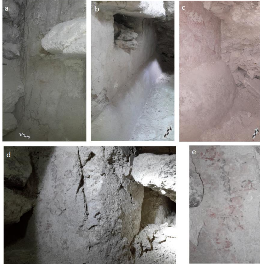
Figura 2.15. a) Esquina sur del muro HOL.T.107.14; b) Ventana y moldura HOL.T.107.24; c) Esquina norte del muro HOL.T.107.14; d) Restos de pigmentos del muro HOL.T.107.14; e) Acercamiento de los restos de los pigmentos del muro HOL.T.107.14, (Foto: Berenice García Vázquez).
