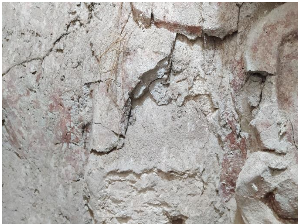
Figura 9.5. Detalle desprendimientos y pérdida de material.
