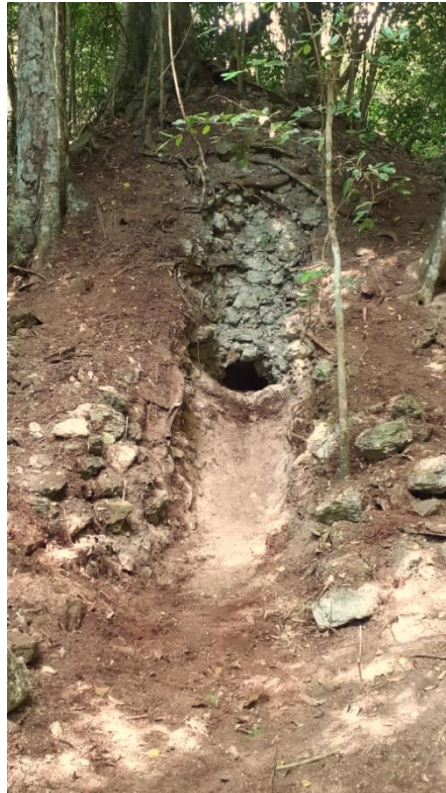
Figura 4.2. Vista general de daños por saqueo y escombros/CHO.L.09. (Foto E. Zambrano).
