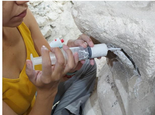
Figura 9.29. Proceso de consolidación. Se puede observar que se aprovecha la separación entre estratos para introducir la lechada de cal.
