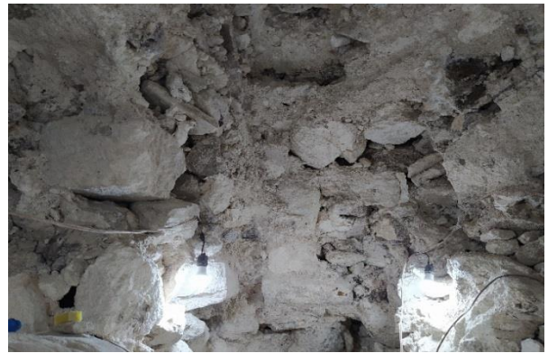
Figura 9.25. Estado de los sillares y juntas constitutivas del túnel perteneciente al mascarón.
