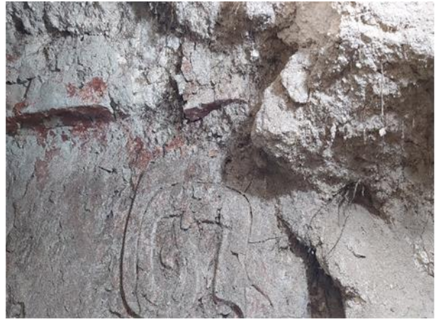
Figura 9.4. Detalle del Muro Norte donde se puede observar la pérdida de material por el crecimiento de raicillas.
