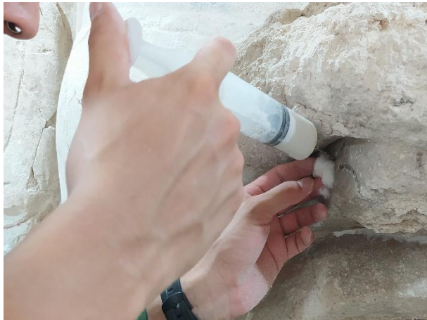
Figura 9.28. Detalle de consolidación por medio de inyección de lechada de cal 2:1.
