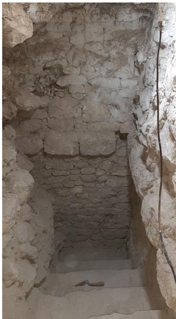
Figura 3.72. Túnel este realizado para descubrir el friso, se pueden apreciar las gradas del contexto CHO.T.10.5 y el muro con tablero superior CHO.T.10.22. (Foto C. Enriquez).
