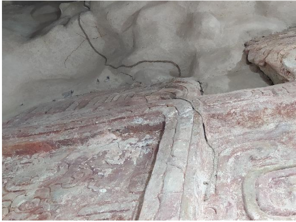
Figura 9.6. Detalle de nido de comején, donde se puede observar que recorre desde la superficie del friso hacia el túnel.
