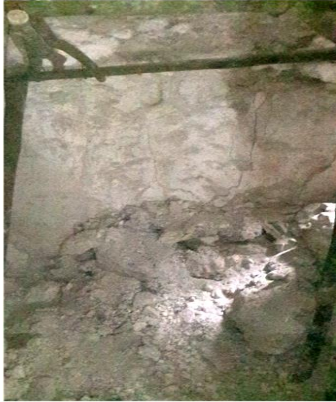
Figura 2.2. Fachada oeste del muro HOL.T.107.14 (Foto: Berenice García Vázquez).
