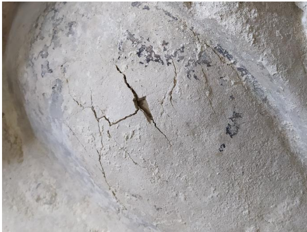
Figura 9.22. Detalle de grietas, fisuras y deformación de plano en el mentón.
