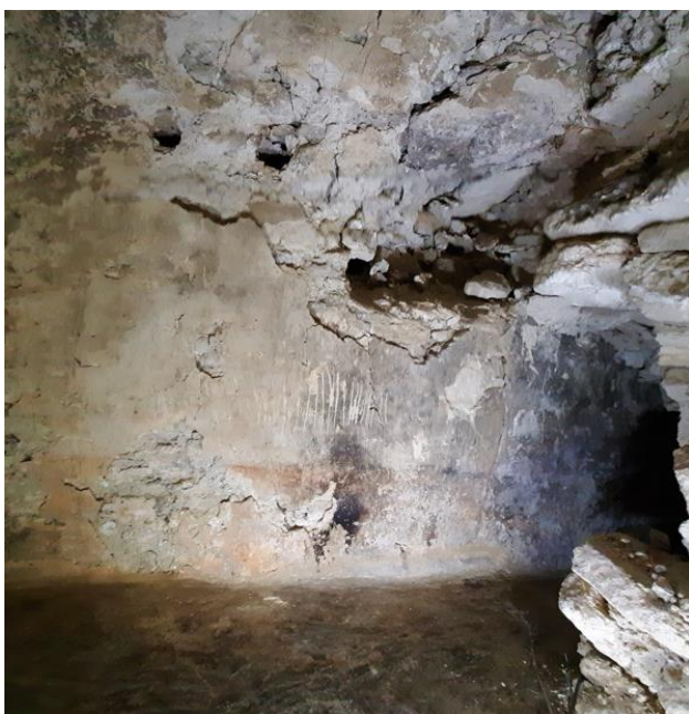
Figura 3.59. Muro norte de la sección oeste del cuarto 2 (CHO.L.12.8). (Foto C. Enríquez).
