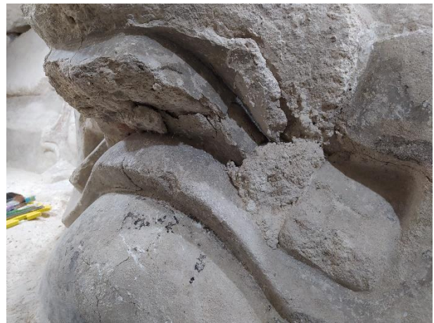
Figura 9.17. Se observan los desprendimientos correspondientes a la boca y nariz, así como restos del relleno constructivo.
