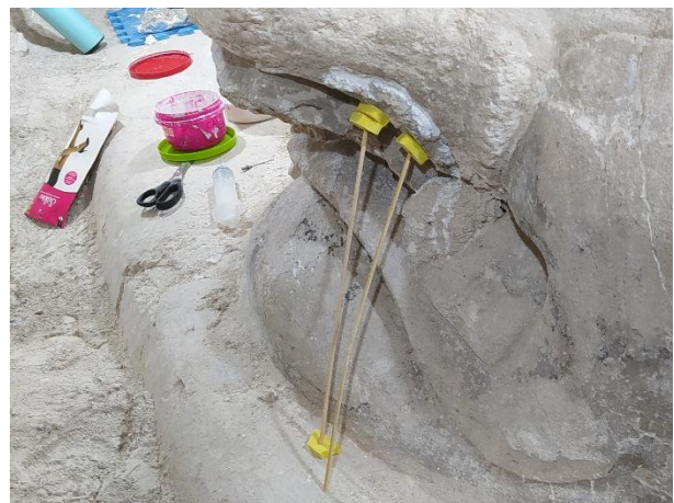
Figura 9.35. Implementación de puntales para asegurar el correcto anclaje entre elementos.
