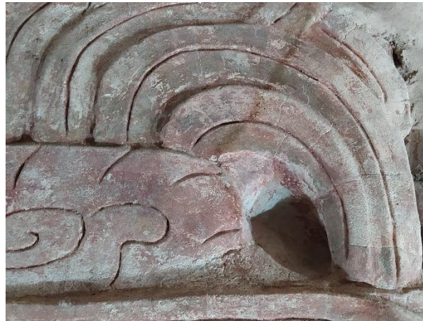
Figura 9.15. Se observa la alteración cromática en superficie por la anidación del comején.
