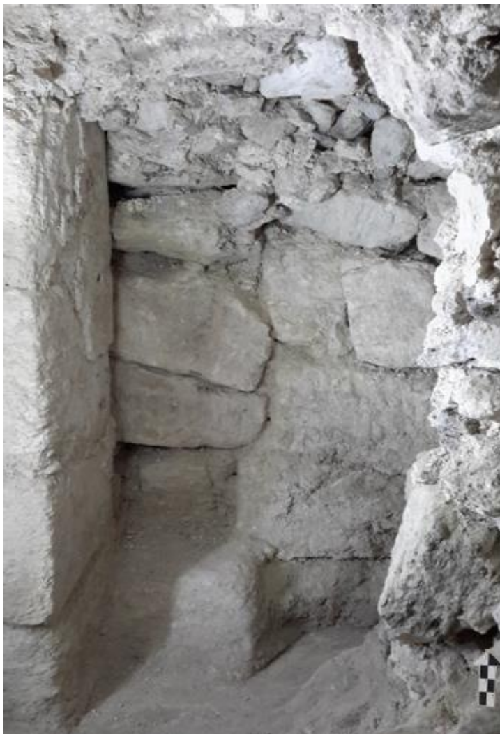
Figura 2.3. Vano de acceso tapiado y ubicado al norte HOL.T.107.18 (Foto: Berenice García Vázquez).
