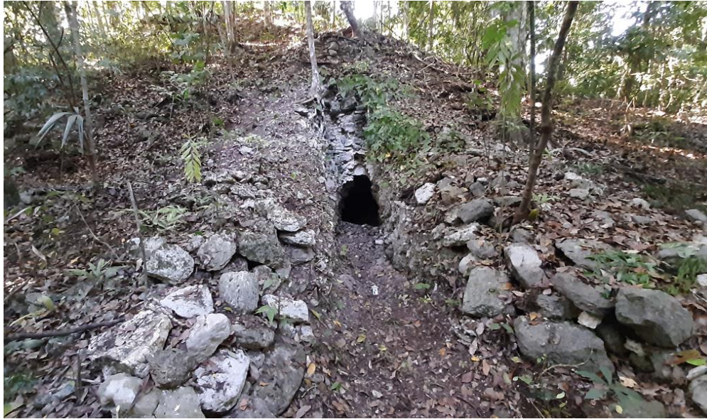
Figura 3.49. Trinchera de saqueo ubicada en la parte oeste del edificio. (Foto C. Enríquez).
