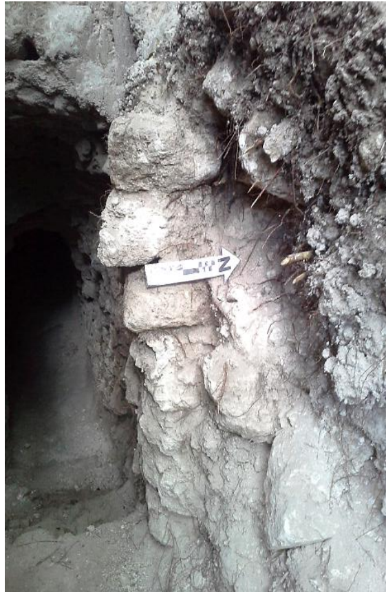
Figura 7.20. Muro de contención CHO.L.08.03) parcialmente destruido. (Foto Bhanny Girón).
