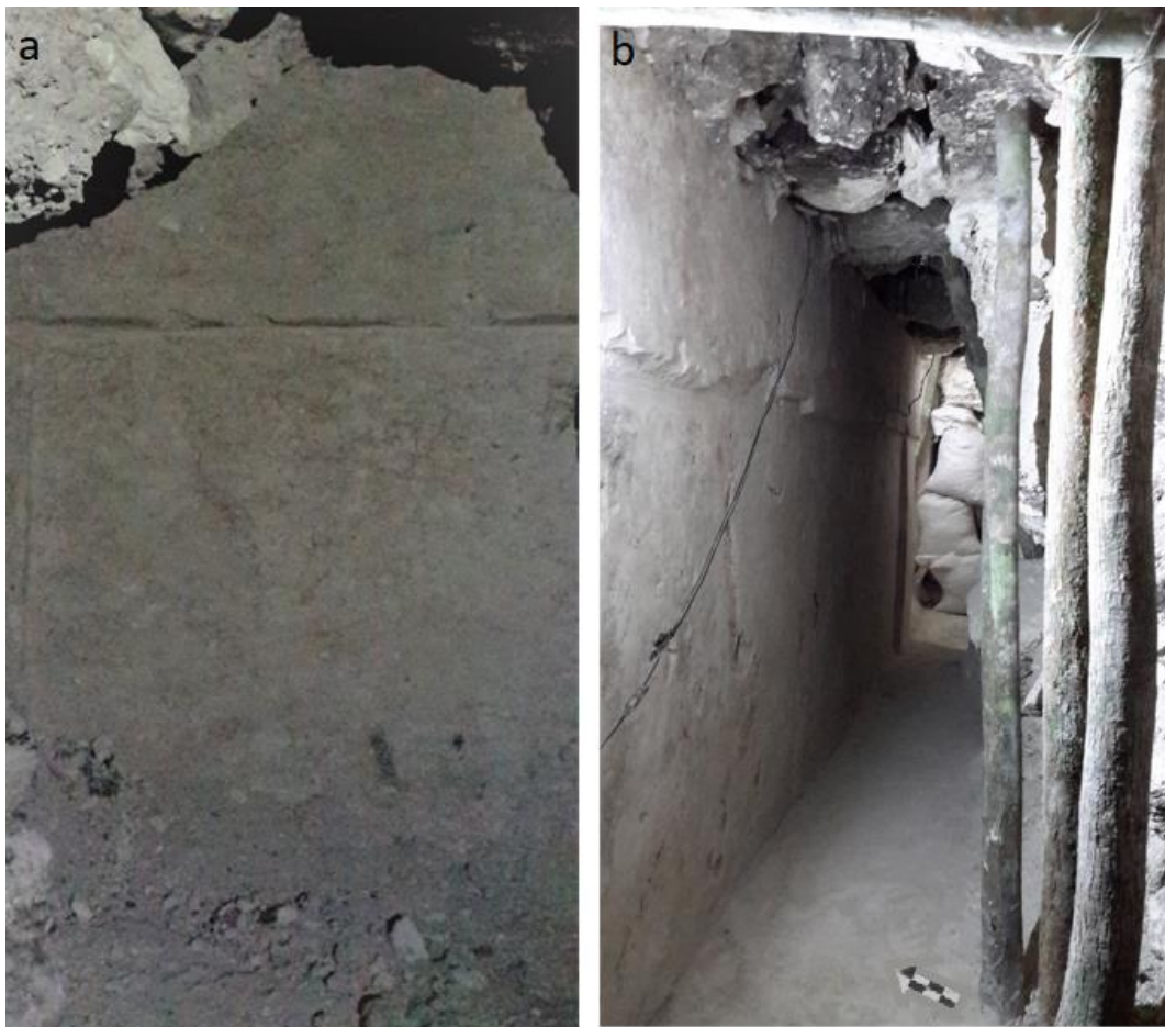
Figura 2.22. a) Vista sur del extremo oeste del muro HOL.T.108.11, en el momento de su descubrimiento; b) Vista oeste con dirección al este del muro HOL.T.108.11 (Foto: Berenice García Vázquez).
