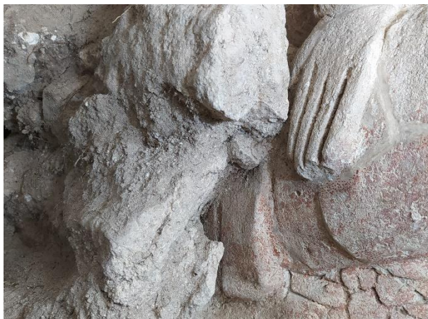
Figura 9.8. Detalle de presencia de relleno constructivo en la Esquina Noroeste. Se pueden observar piedras, tierra y posible mortero de junta.
