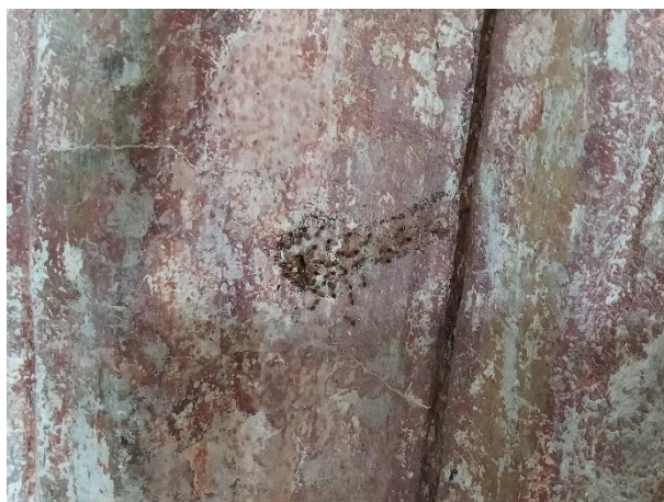
Figura 9.12. Detalle de presencia de comején.
