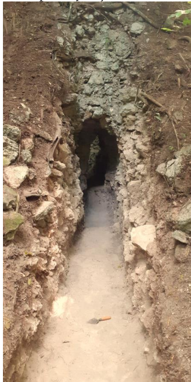
Figura 4.3. Vista desde el oeste hacia túnel de acceso luego de limpieza y remoción de escombros. (Foto Enrique Zambrano).
